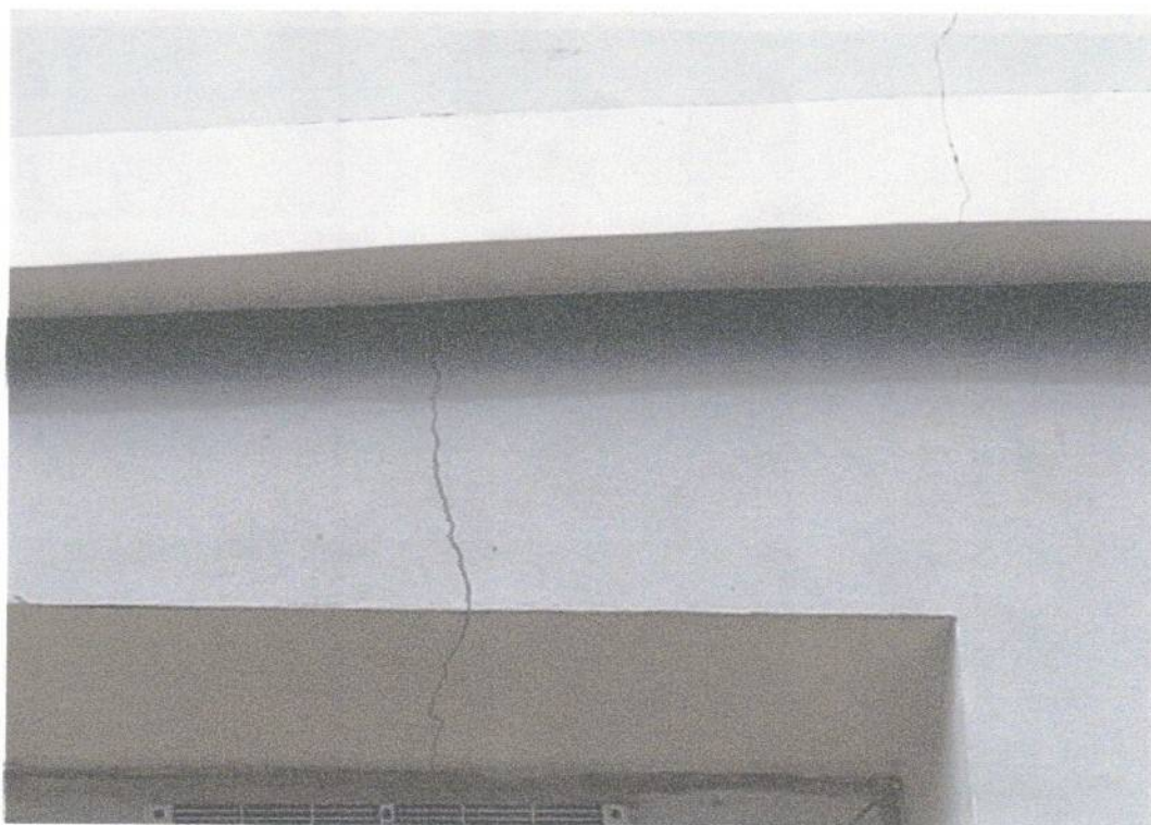
Fot. nr 2. Ściana wschodnia
